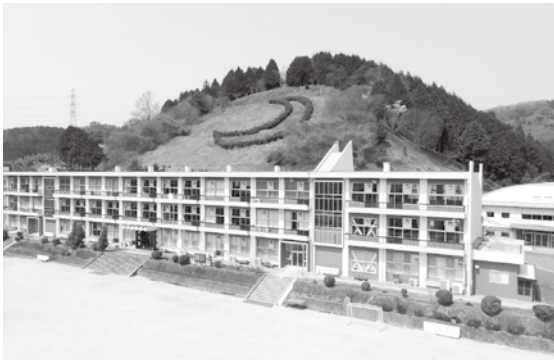
▲昭和 41 年建築の三日月小学校
