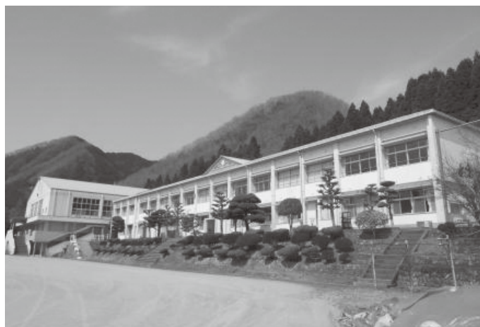
▲昭和 49 年建築の上津中学校
