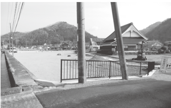
▲拡幅後の町道に残る電柱と工事が進む新駐車場
