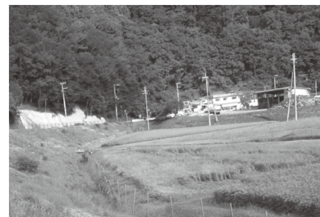
▲きれいに草刈りされた国道373号線のり面（円光寺）
