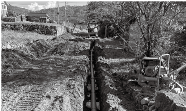
▲上水道管（石綿管）更新工事
