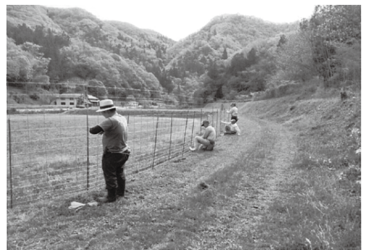
▲侵入防止柵の設置状況
