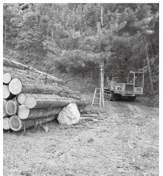
▲森林再生に向けた現場の状況
