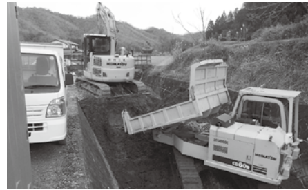
▲須山川土砂浚渫工事
