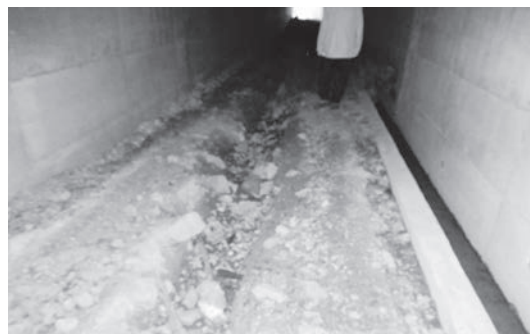
▲中国道カルバート内の路面
