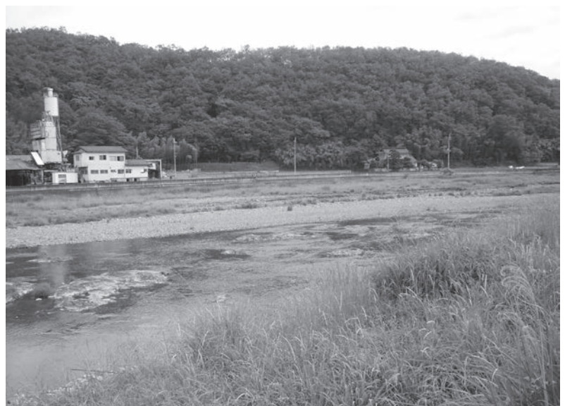
▲堆積土砂を川の中に置いてしまったため水が出て流れてしまった河川
