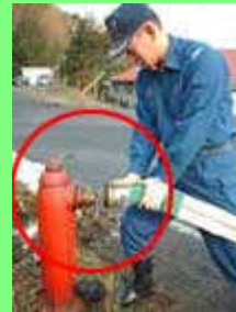
(地上式消火栓)
