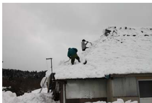
■屋根からの雪下ろし
