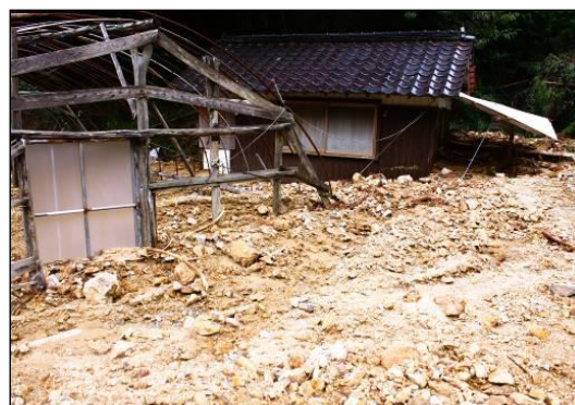
土砂による家屋被害
