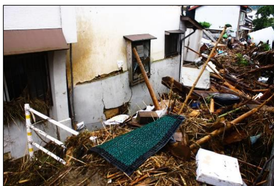
河川漂流物による家屋被害
