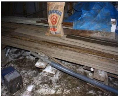
消石灰による床下の消毒
