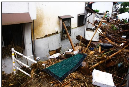
河川漂流物による家屋被害
