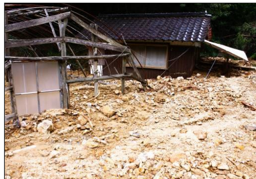
土砂による家屋被害
