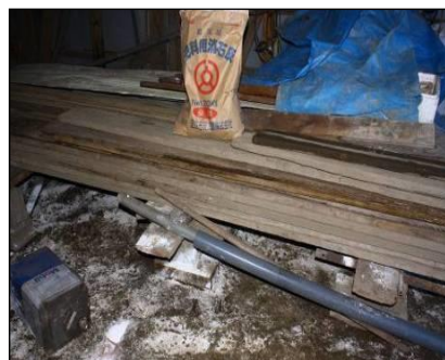
消石灰による床下の消毒
