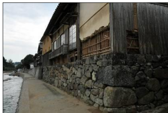
平福景観形成地区の被害状況
