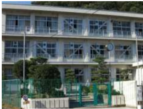
耐震工事後の久崎小学校校舎
