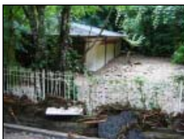
佐用町昆虫館の被害状況
