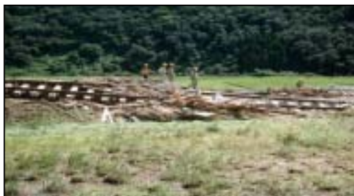
姫新線の被害状況【佐用町早瀬】
