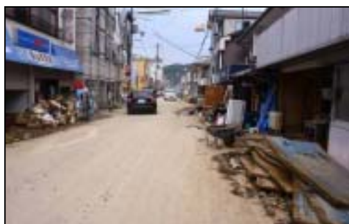
商店街の被害状況【佐用商店街】
