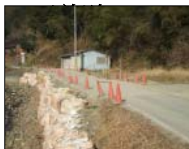
道路の応急工事【佐用町須安】
