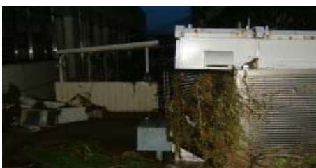
上月支所駐車場
