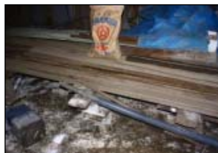
消石灰による床下の消毒
