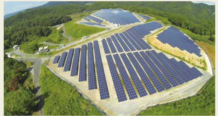
▲国内で初めて木造建築構造の架台を採用
