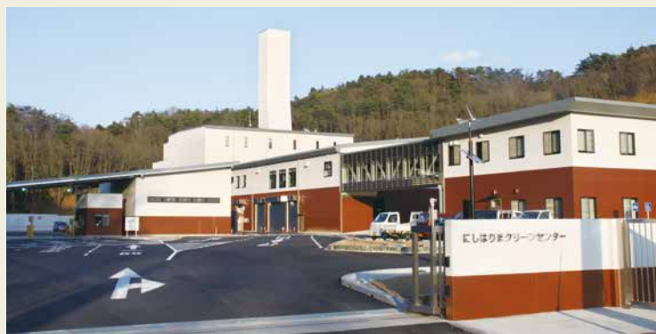
▲ごみを効率よく焼却処理する「熱回収施設」と資源ごみの再資源化を図る「リサイクル施設」を備える「にしはりまクリーンセンター」
