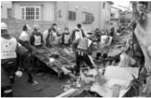
▲生活道路のガレキ除去を行っている様子
