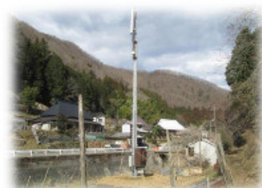
携帯電話基地局の整備
