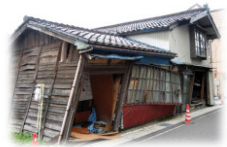
危険空き家 (出典：消防防災科学センター)
