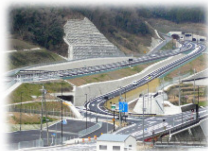
鳥取自動車道 佐用平福インターチェンジ
