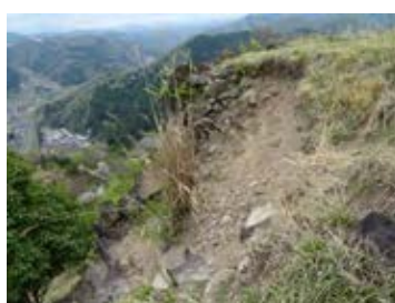
写 3-21 二の丸西 崩落部
