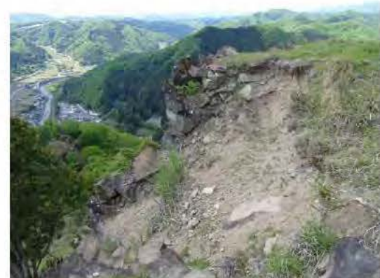
写 6-16 タ. 二の丸西区 隅角部の崩落
