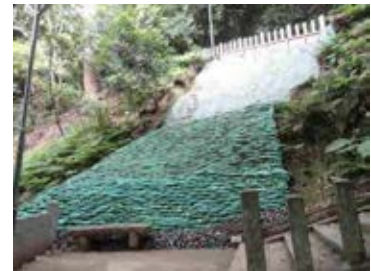
写 9-6 法面土嚢工事例（法面）
