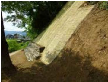
写 9-4 マット工、じゃかご工事例
