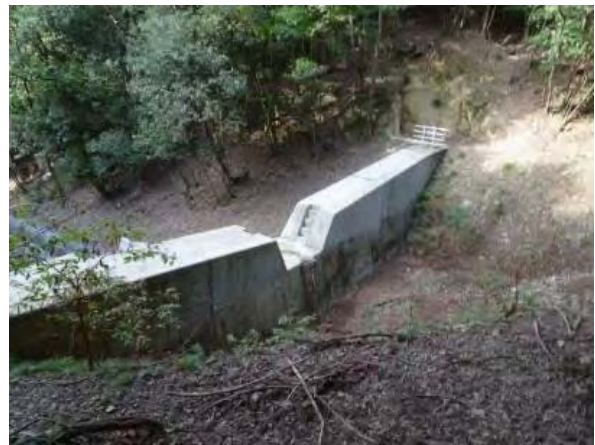
写5-8 ②砂防ダム（平成27年整備）
