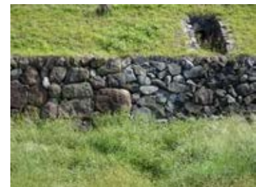
写5-14 ⑥復元的に整備された護岸
