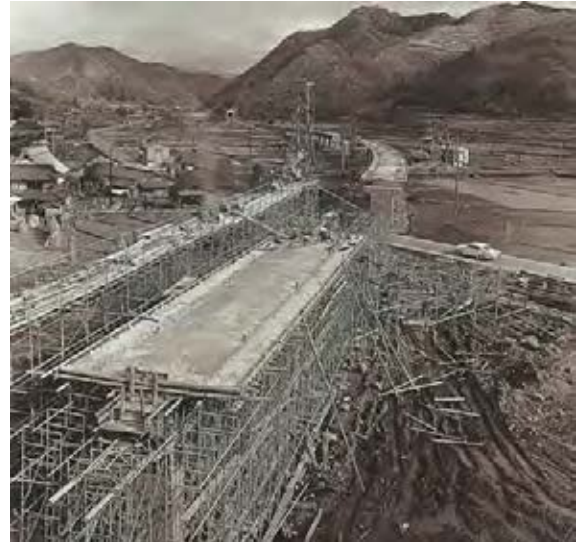
写2-11 昭和42年(1967)国鉄智頭線工事
