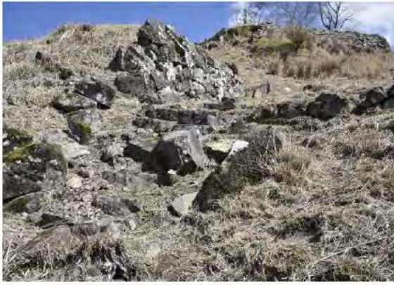
写 6-9 ケ. 三の丸南面石垣
