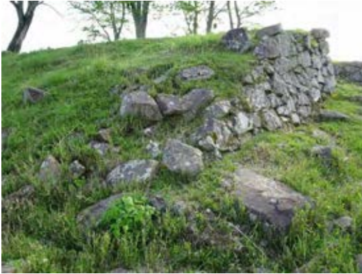
写 6-3 ウ. 天守虎口東石垣端部崩落
