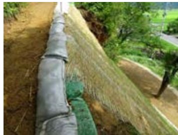
写 9-5 排水工事例（法肩流出防止）
