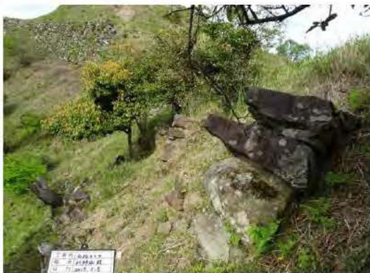
写 6-13 ス. 三の丸南西斜面石垣端部
