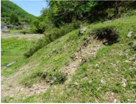
写 6-17 チ. 御殿屋敷地区登城道付近斜面
