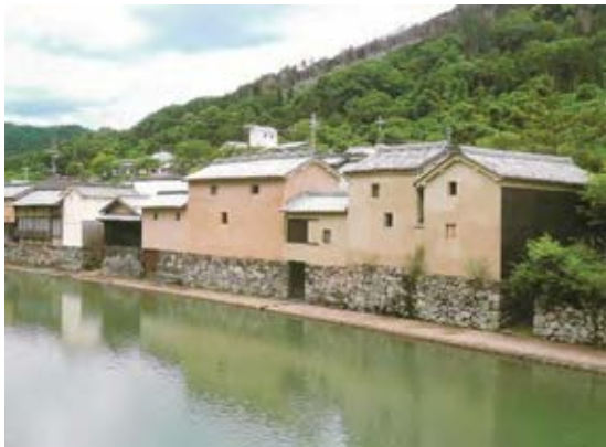
写4-2 佐用川に面した川端風景 平福の町家の特色をそなえた建造物で、兵庫県の景観形成重要建造物に選定されている
