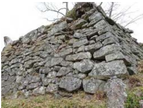
写 3-23 天守丸南東石垣隅角部
