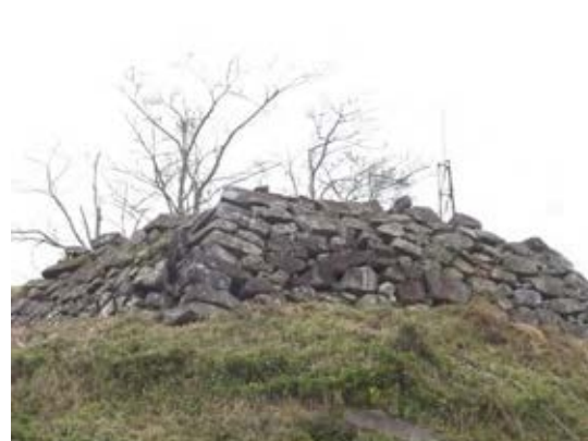
写 3-9 山城跡 天守丸西石垣（南西より）
