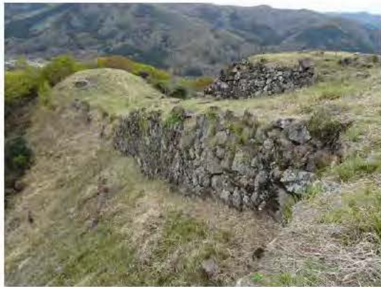
写 6-11 サ. 三の丸南面石垣
