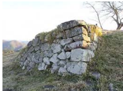
写 3-24 天守丸東石垣隅角部
