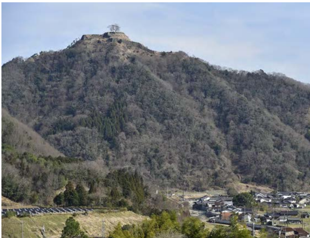
写5-25 ①友延付近（因幡街道）より利神城跡を望む
