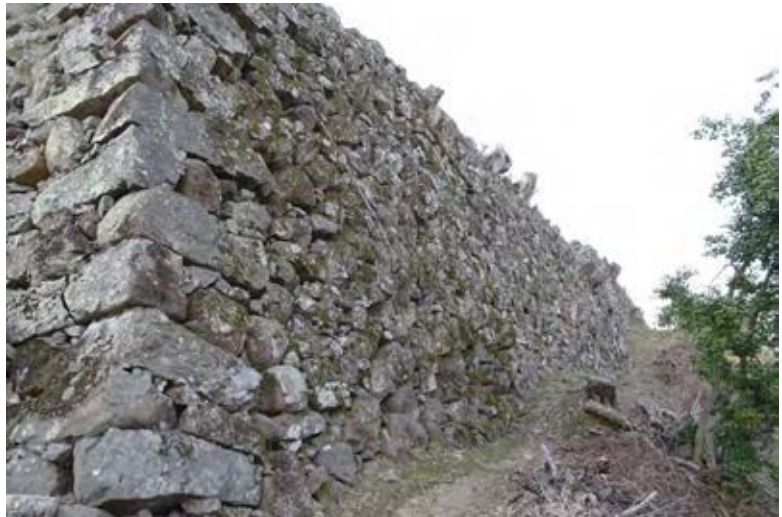
写 3-25 本丸南東石垣隅角部
