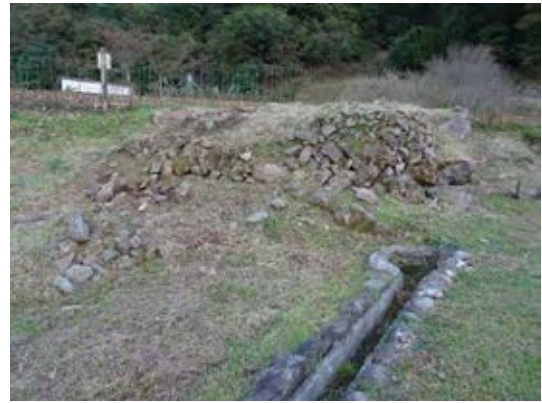
写 6-18 ツ. 御殿屋敷地区線路沿い石垣一部崩落
