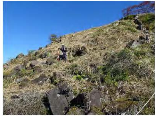
写 6-10 コ. 二の丸西区法面崩落石散在
