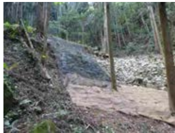
写 9-2 落石防止網、マット工事例
