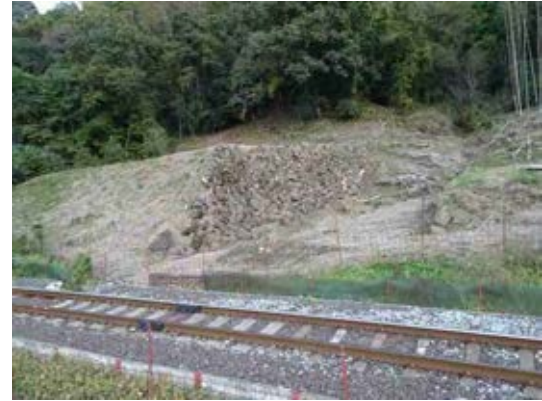
写 6-22 ニ. 線路による分断部（南石塁山側）
