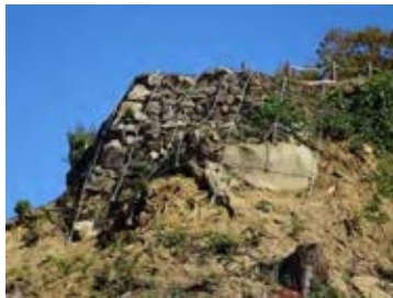
写 9-1 落石防止網工事例
