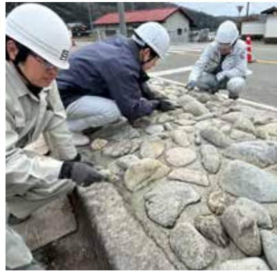
玉石を設置する様子
