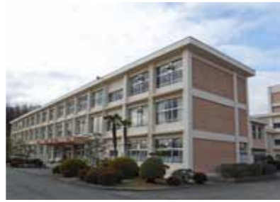
【佐用中学校外壁・屋上改修事業】 事業費：1億717万円
