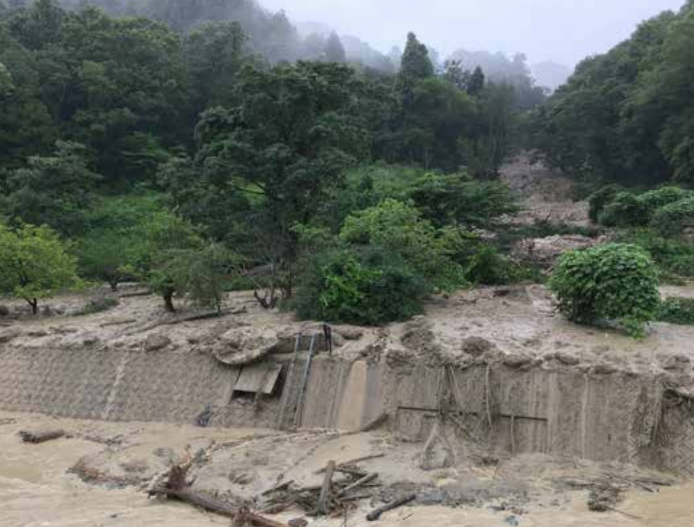
平成 30 年 7 月豪雨での土砂崩れ
