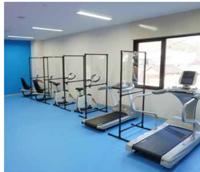
交流広場に新設したトレーニングコーナー
