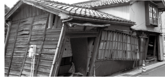
朽ちて傾いた危険空き家（出典：消防防災科学センター）
