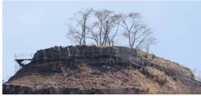
応急対策工事中の利神城跡
