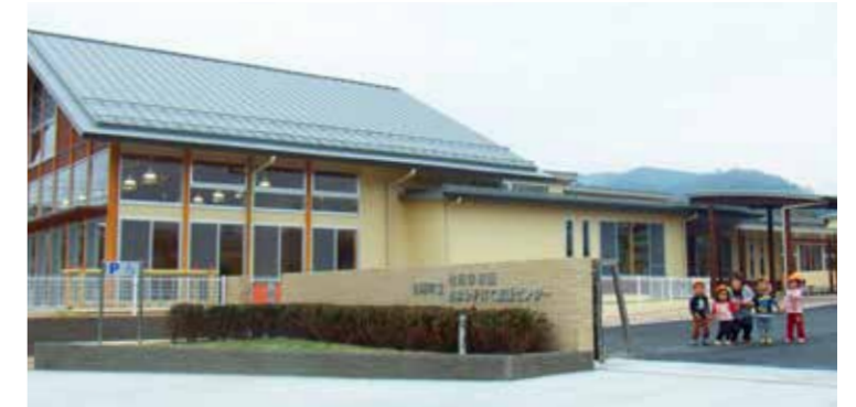
台風第9号災害の影響で約1か月遅れで完成した「さよう子育て支援センター」
