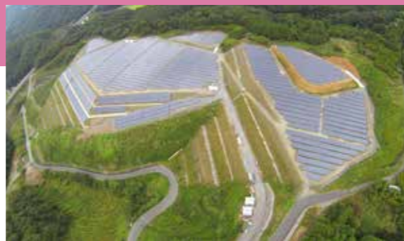
上空から見た 申山太陽光発電所
