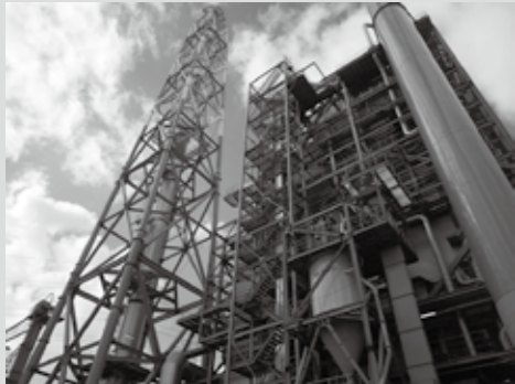
(株)日本海水の発電設備（赤穂市）
