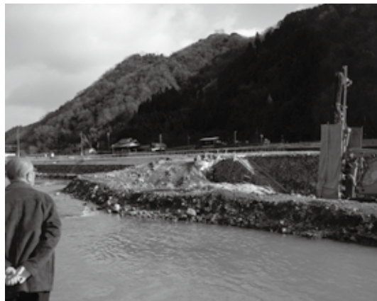
改修が進む佐用川。対岸には3分ほどの遊歩道が新たにできる予定です
