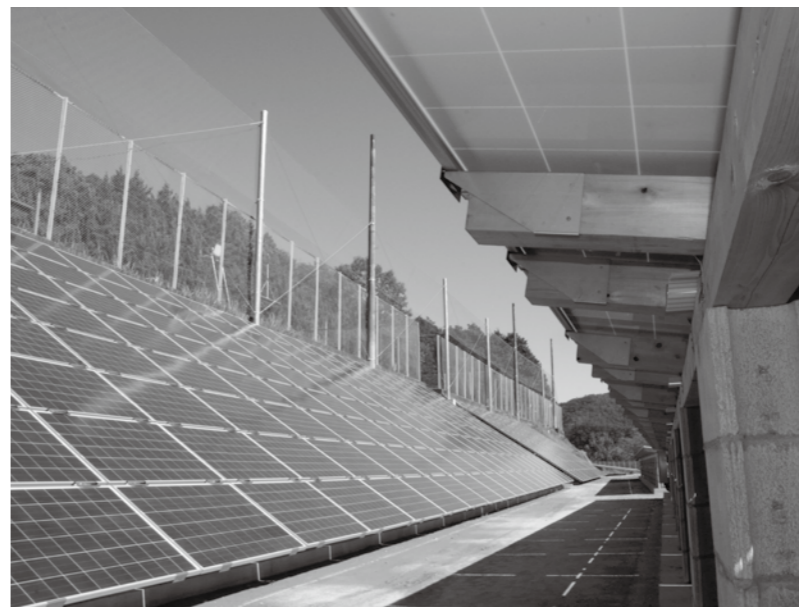
上月小学校裏の町有地に建設した木製架台採用の太陽光パネル
