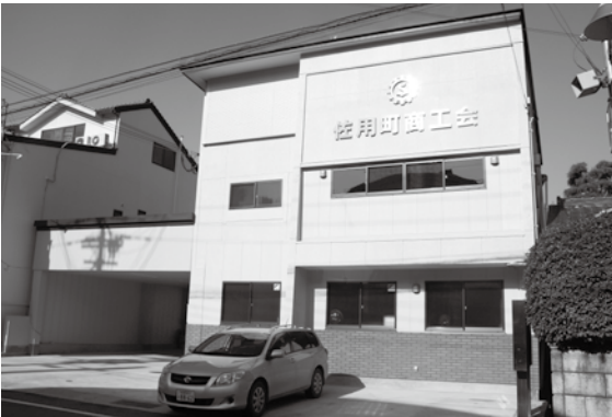
改修工事を終えた町商工会館
