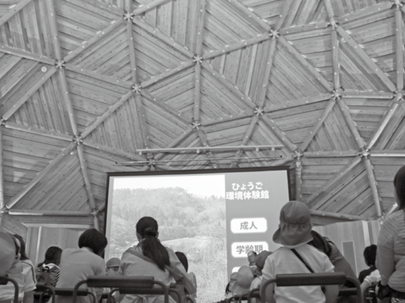
シアター内部。館内は1,400本の間伐材を使ったトラス構造で建築されました
