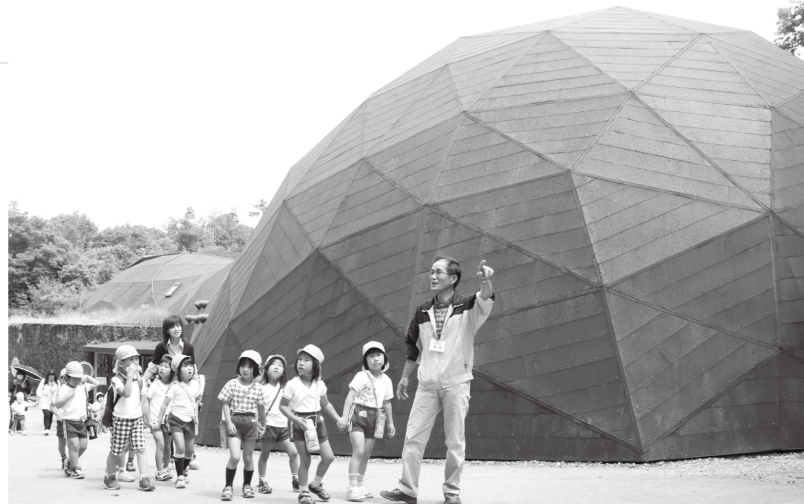
エコハウスの外壁は屋根、外部壁面に塗料を使用しないさび加工した鋼板を使用しています。体験講座は館内だけでなく周辺の自然にふれる体験もあります
