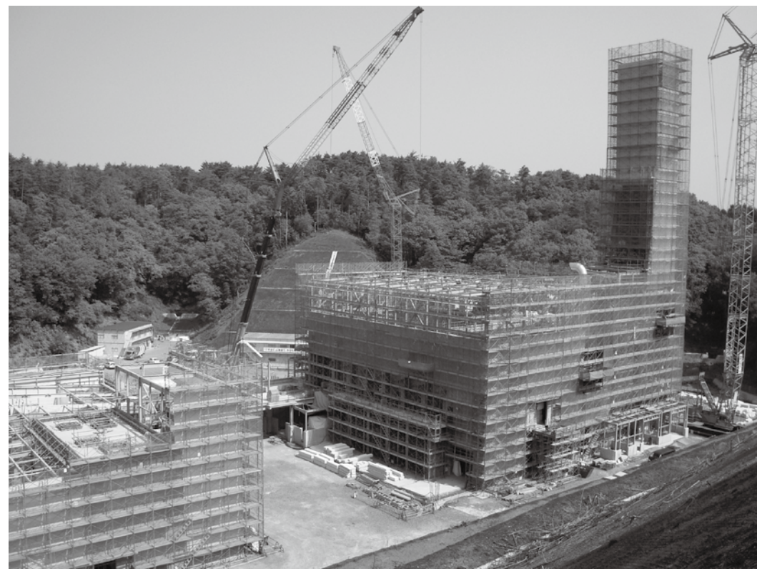
建設が進む新クリーンセンター
