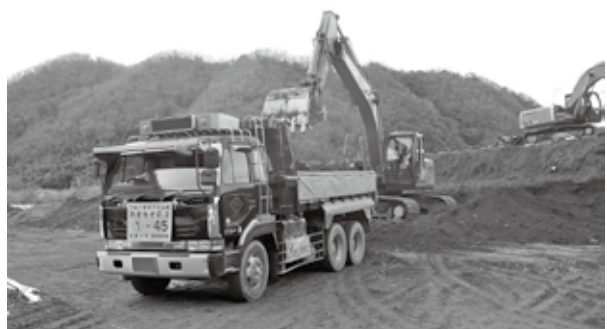
(写真上) 工事が進む佐用川 (写真下) 河川改修の残土運搬のゼッケンをつけて土砂を搬出するダンプカー
