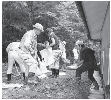
昆虫館の復旧作業のようす
