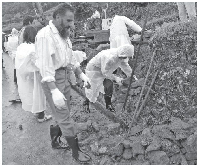
小雨のなか行われた石垣積み技術研修
