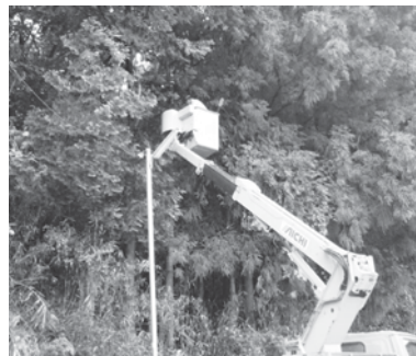
高所作業車での木伐採作業
