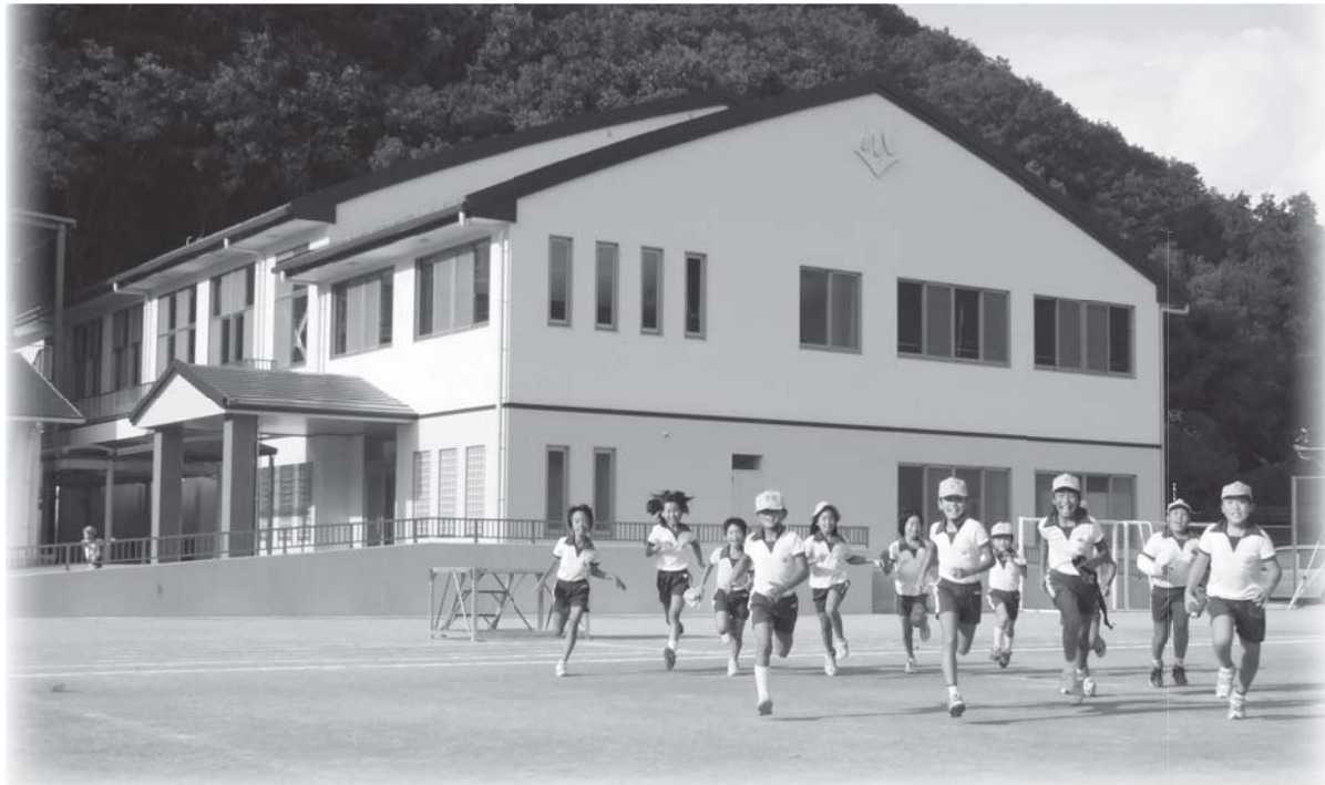
平成18年度に改築した久崎小学校体育館
