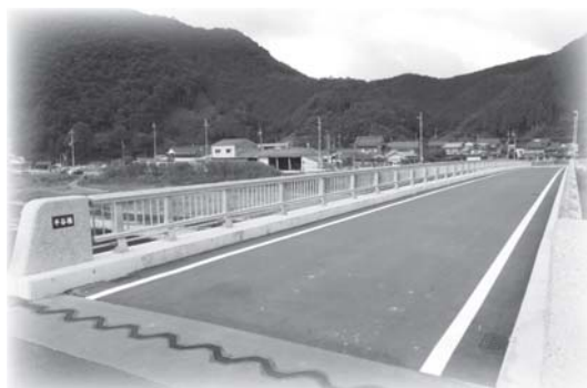
平成 18 年度に建設された平谷橋 (櫛田)
