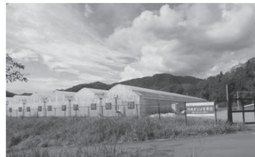
▲トマト栽培ハウス(旧三土中学校跡地)
