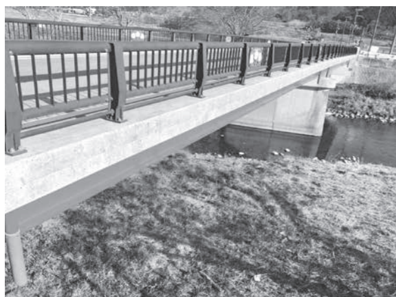
▲修理が完了した久保大橋
