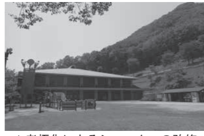
▲老朽化によるシャッターの改修
