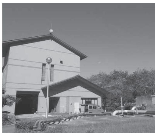
▲汚泥集約化事業が完了した三日月浄化センター
