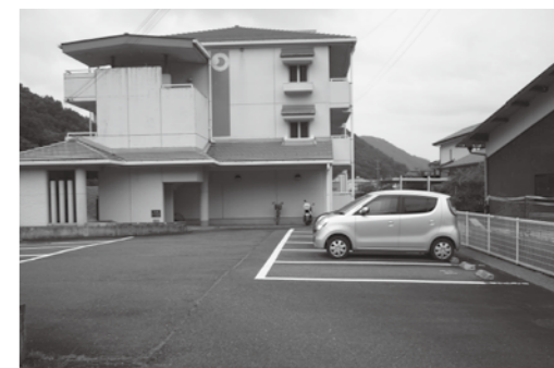
▲空室のめだつ町営住宅
