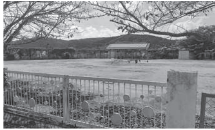
▲整備中のいこいの広場
