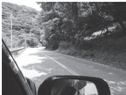
▲国道 373 号線 (石井付近)
