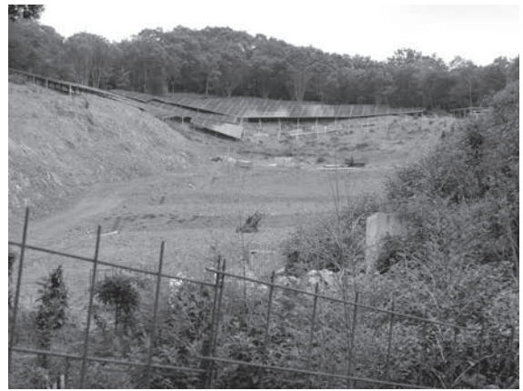
▲工事中断中の太陽光発電施設（早瀬）
