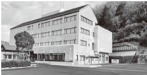
▲ 三日月支所の改修と文化センターの除却
