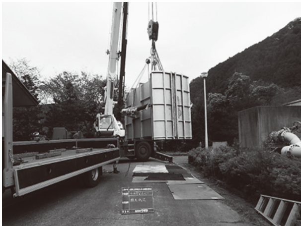
▲ 三日月浄化センターの長寿命化工事
