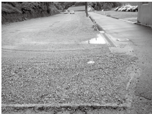
▲ 三日月折口町営住宅用地
