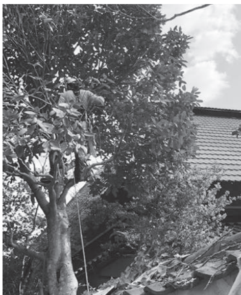
▲空き家の維持管理の様子
