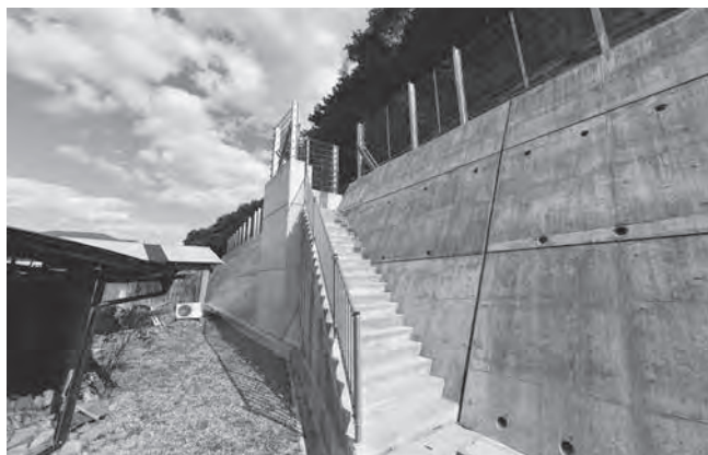
▲急傾斜地崩壊対策工事（佐用新町）
