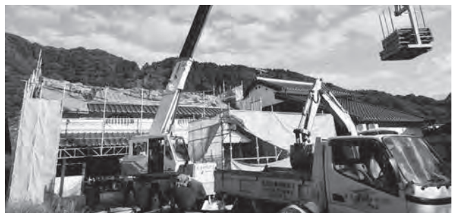
▲改築工事が進む旧木村邸 (平福)
