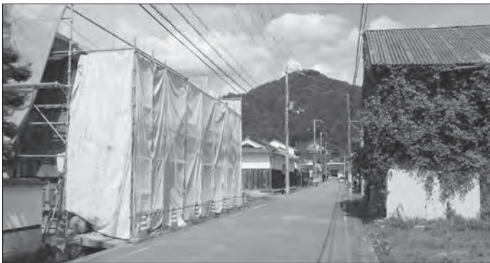
▲（左）工事中の木村邸母屋（右）活用計画中の木村酒造場
