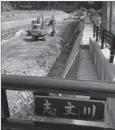
▲県道千種新宮線工事
