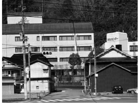
▲改修予定の三日月支所
