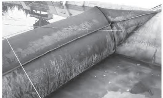
▲ゴム引き布製起伏堰（風船ダム）資料写真
