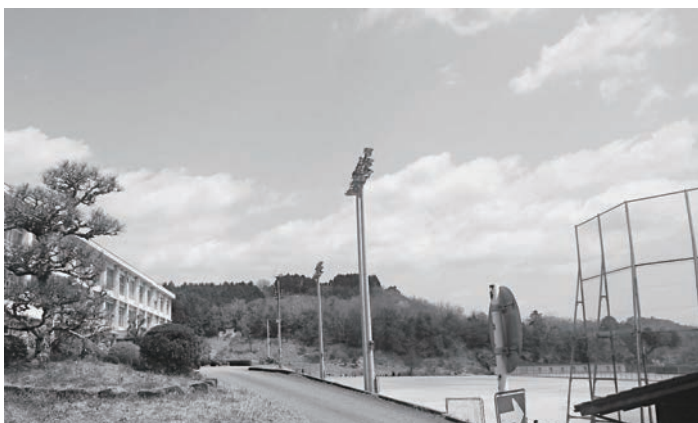
▲佐用中学校の照明施設
