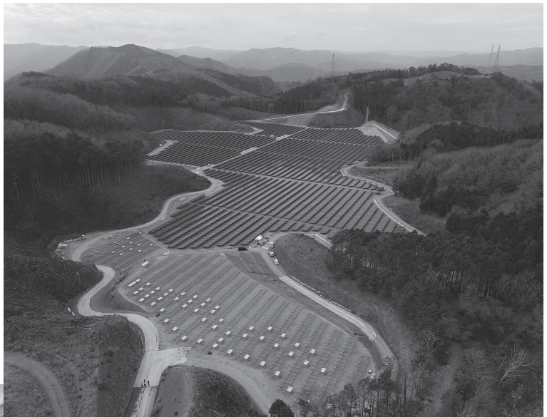
▲秀谷太陽光発電所
