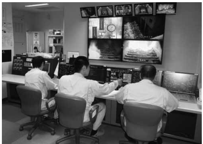
▲にはりまクリーンセンター・中央制御室
