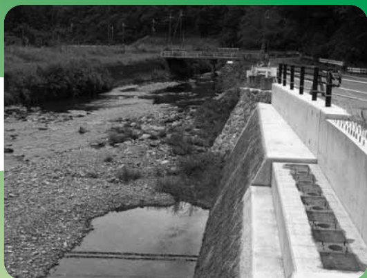
下部工が整備された岩崎橋
