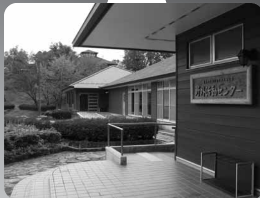
改修された天文台野外活動センター
