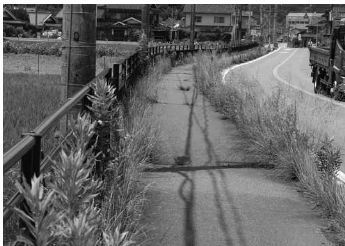
▲土砂で草が多く繁茂している道路
