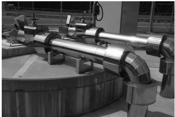
真盛の水道施設
