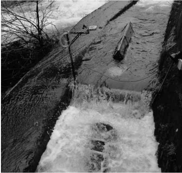
▲岡山県西栗倉村の小水力発電施設
