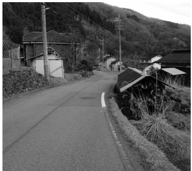
▲幅員が狭小な真宗・問村付近
