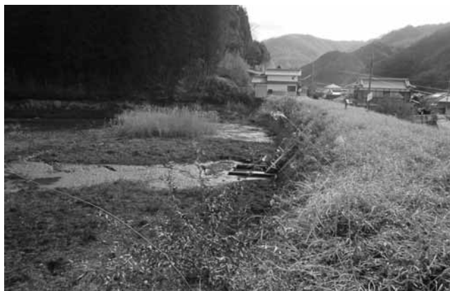
▲修理しても修理しても水が漏る慈方寺池
