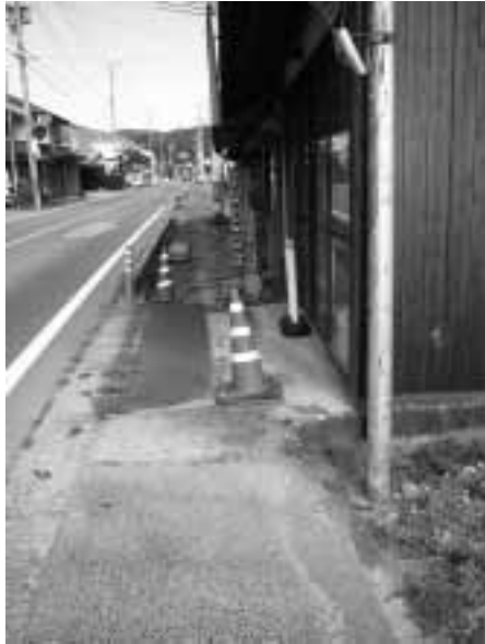
▲段差があり未買収の危険な歩道
