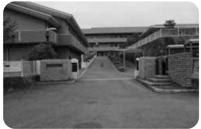
▲平成17年建設の上月中学校
