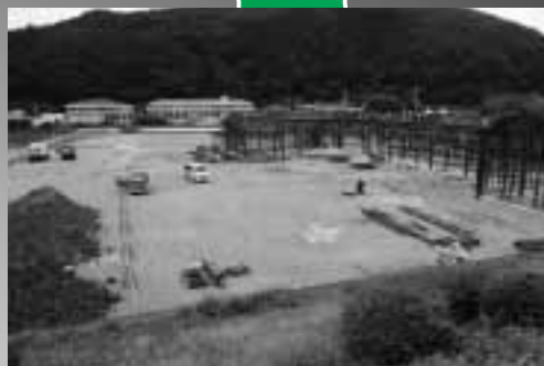
▲(仮称)南光地域保育園造成 建設予定地の土地購入費 (写真はH28.10現在のものです) 7,689万円
