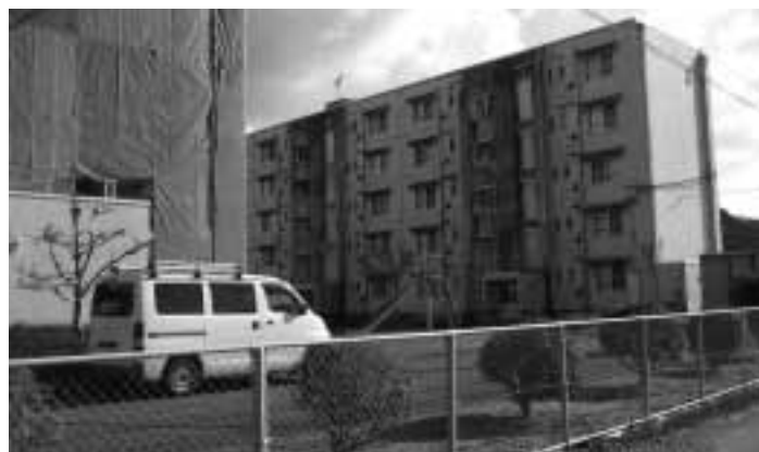
▲改修中の定住促進住宅
