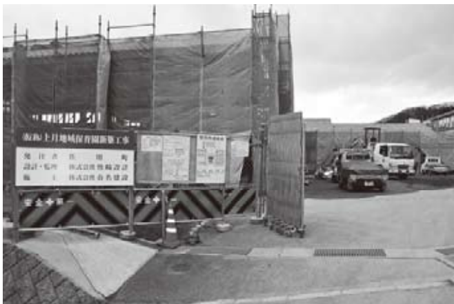
▲ 建設中の保育園(上月地域)
