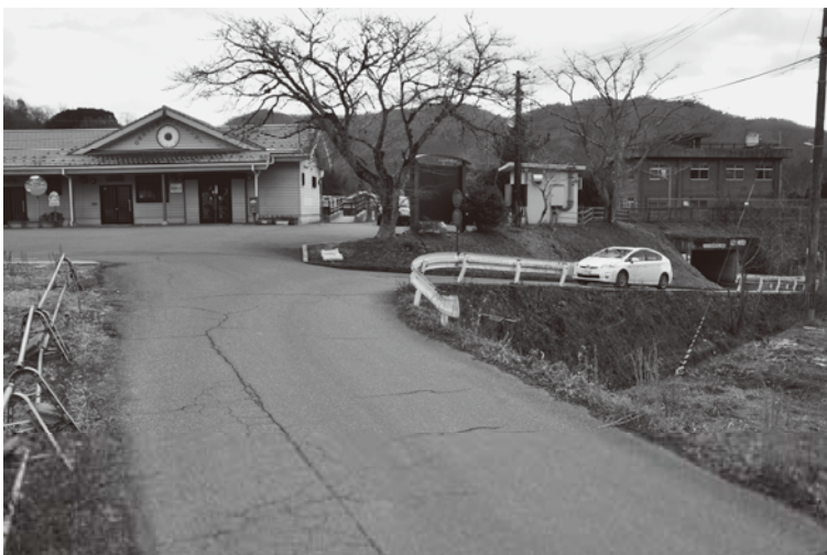
▲ 町道小山安川線道路改良事業地
