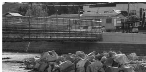
▲佐用大橋右岸管渠移設工事
