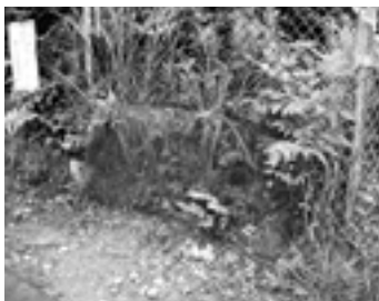
▲地元修理された中国道防護フェンス
