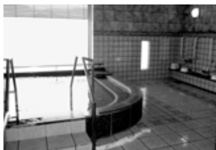
▲改修される南光地域福祉センター浴室
