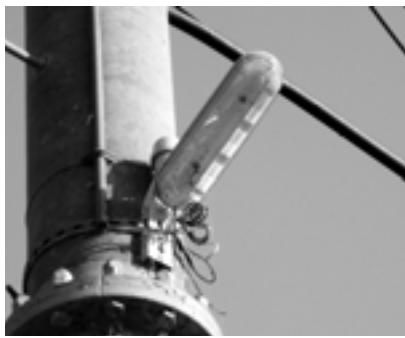
▲LED化された防犯灯
